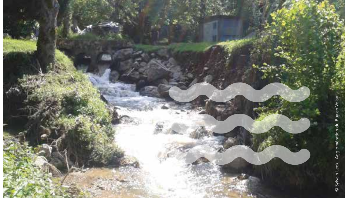
▲ Exemple d'érosion en aval de buses suite à une crue.
