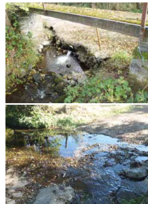
▼ Exemple avant / après suppression d'un passage à gué busé.
