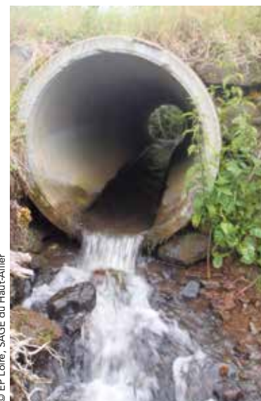
► Exemple de chute à l'aval d'une buse sur le Freycenet.
