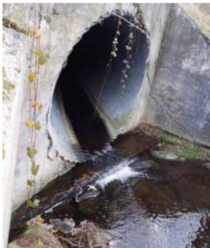
► Exemple de buse sur le Cizière
