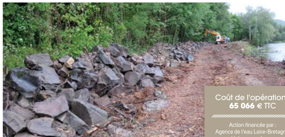
Travaux de désenrochement de la berge de l'Allier Automne 2017 - Cen Auvergne - J. SAILLARD
