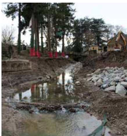
Travaux de modification confluence Sarmon-Allier - Vichy Communauté
