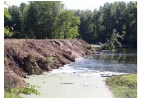
Site de Maringues suite aux travaux de désenrochement - CEN Auvergne
